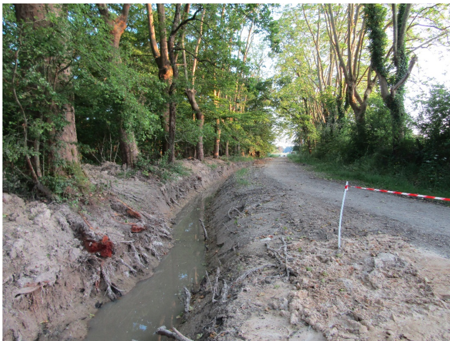
Atteintes à un alignement d'arbres à Orçay commune du Pays de Grande Sologne
